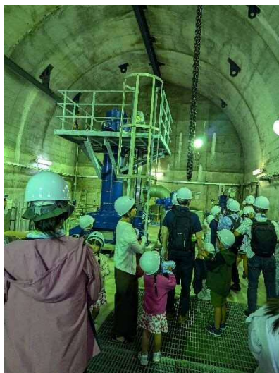
（味噌川ダム監査廊見学）
