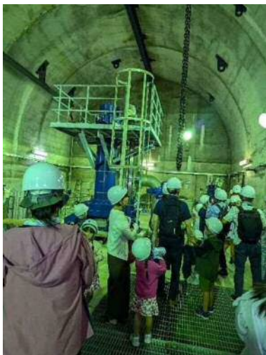
（味噌川ダム監査廊見学）
