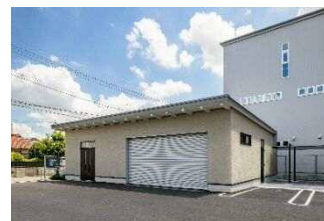
倉庫・車庫棟
