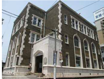
旧・尾西繊維協会ビル。 リノベーション
