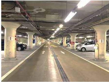
市営駅東・銀座通地下駐車場 収容台数254台
