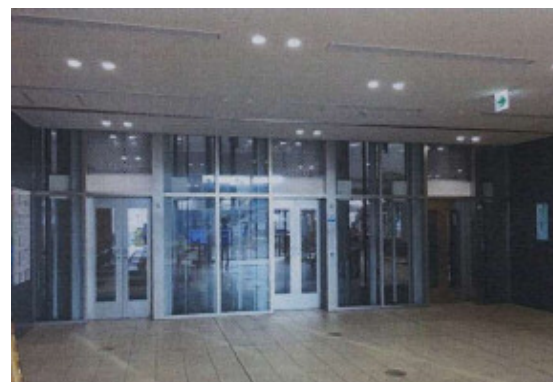
(エレベーター正面)
