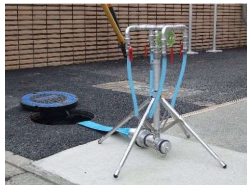
指定避難所の応急給水栓
