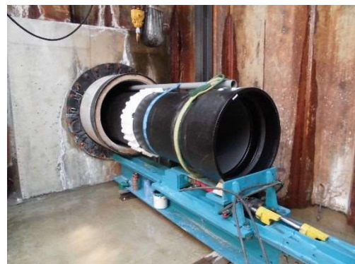
基幹管路の耐震管布設状況
