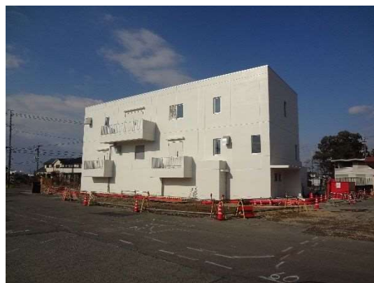
佐千原浄水場第2ポンプ棟建設工事
