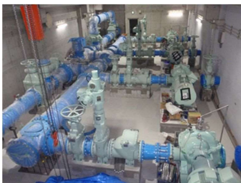
佐千原浄水場第2ポンプ棟建設状況
