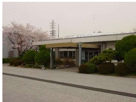
木曽川配水場
