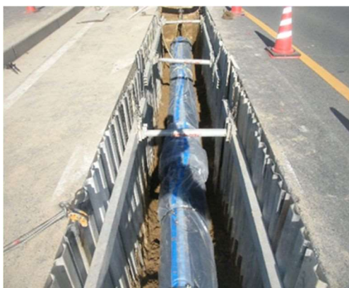
基幹管路の耐震管布設状況
