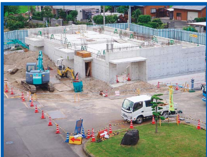
令和元年度は主に建物を建設中です。
