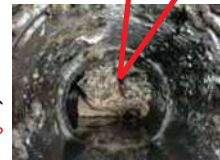
下水道管の内部
