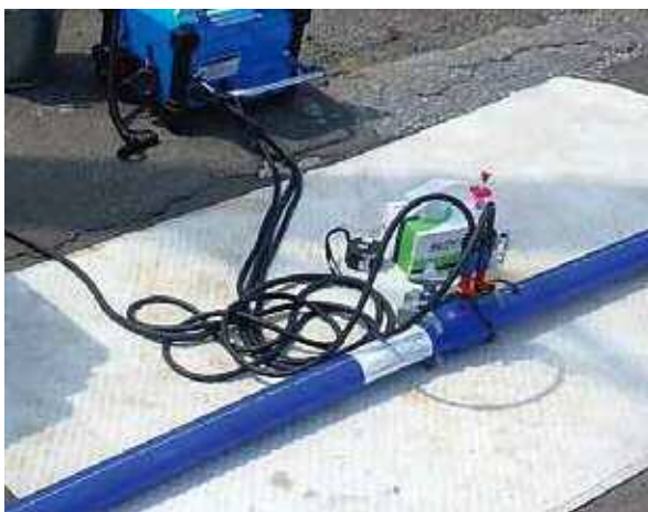
ポリエチレン管の接合状況
