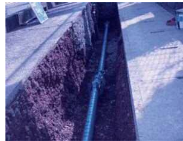
給水ルートの耐震化工事
