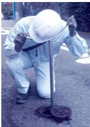
上の写真は断水を行うため、職員がバルブを操作している様子です。バルブの操作には、回転数や水の音を聞き、細心の注意を払いながら行っています。
