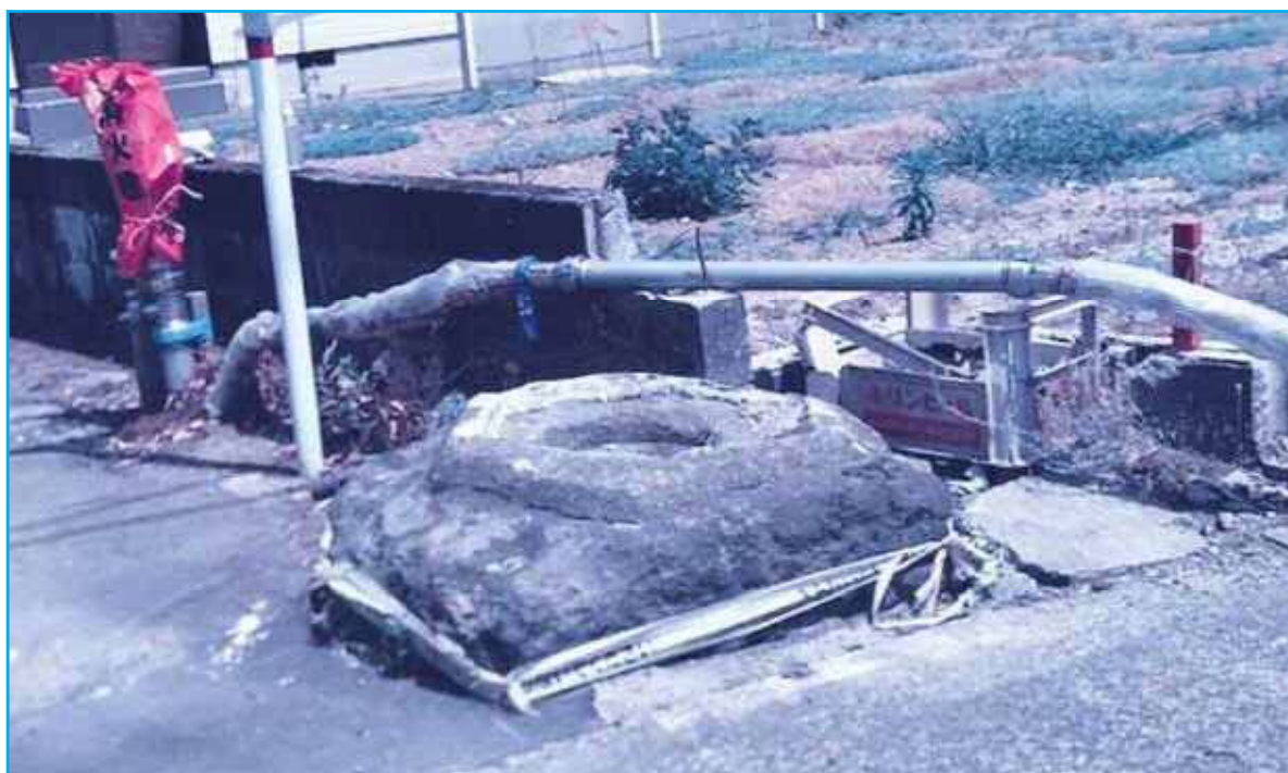
図-2 仮配管による復旧状況 その1
