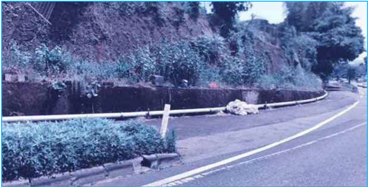
写真提供 一宮市指定水道工事店協同組合(図-2,3とも)
