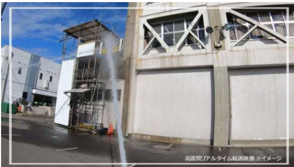
図表14-4-4 消防隊放水・消火活動説明映像 キャプチャ画像
