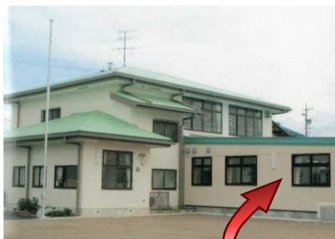
増築された教室部分
