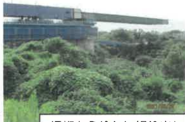
橋桁から徐々に繰り出し
