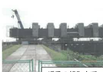
橋梁の組み立て
