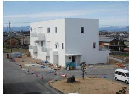
建設中の佐千原浄水場第2ポンプ棟
