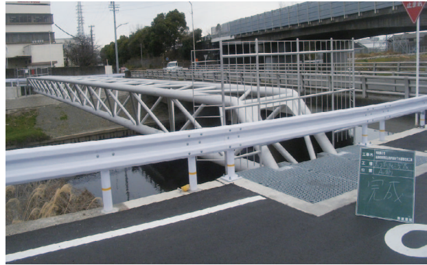
布設替した下水道水管橋（日光川・風張橋・萩原町萩原～西萩原間）
