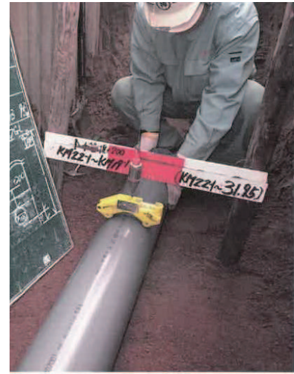
下水道管の布設
