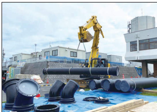
※佐千原浄水場での設備更新工事
