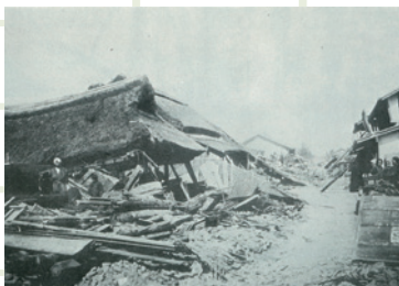
▲濃尾地震後の全壊家屋
