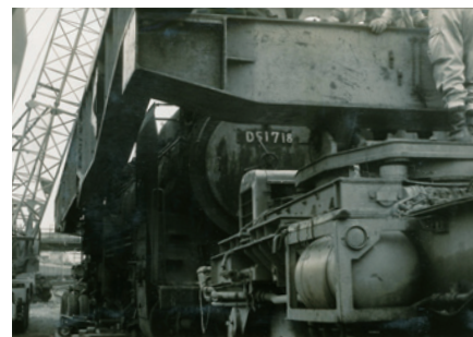
▲特殊トレーラーに積み込みされた蒸気機関車(尾張一宮駅構内)
