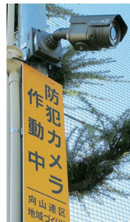
▲防犯対策強化事業 (防犯カメラの設置)
