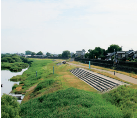
整備された腰掛け階段
