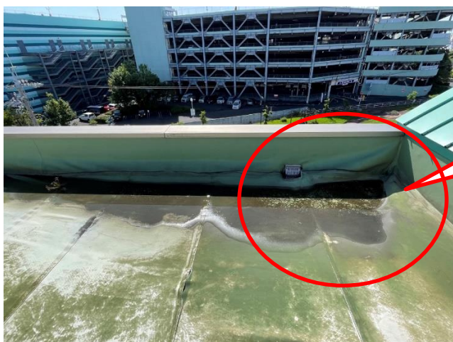
【図表 4-4-24】 高齢者生きがいセンター屋上
