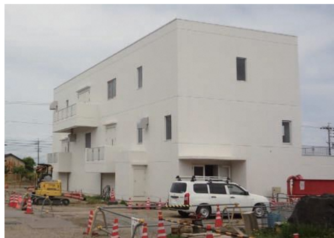
佐千原浄水場第2ポンプ棟
