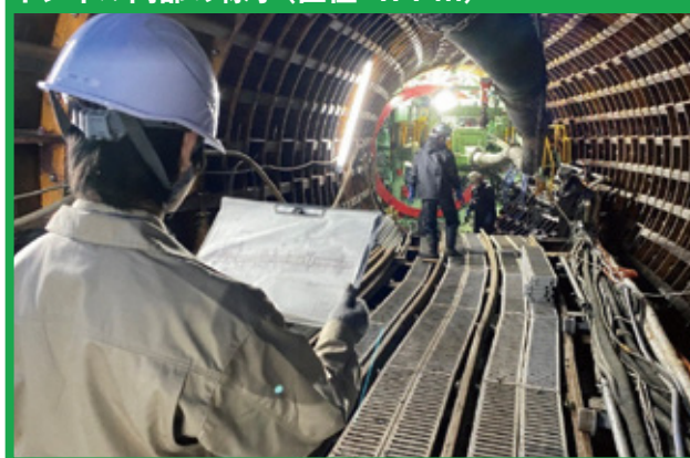
トンネル内部の様子(直径 4.4 m)
