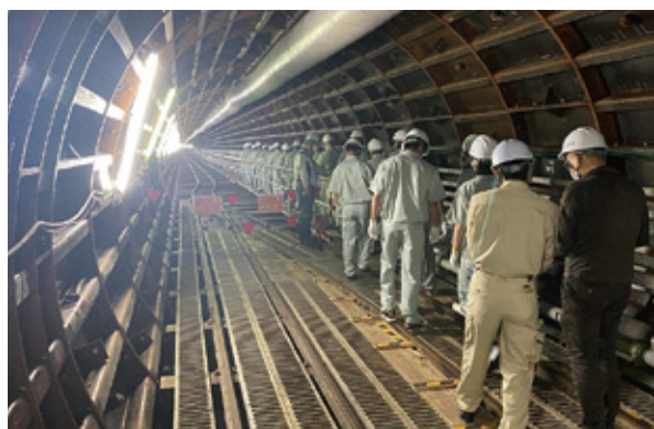
トンネル内の様子
