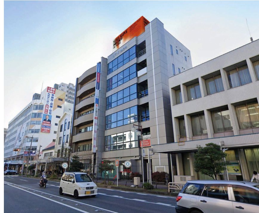
北面(下の道路から)
