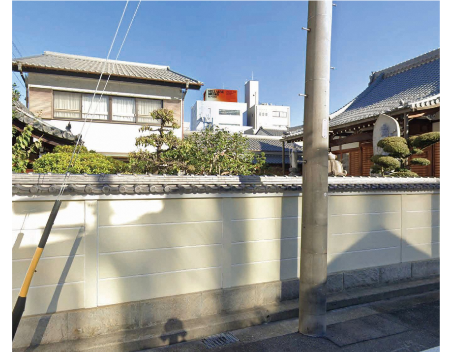
南面(遠目の道路から)
