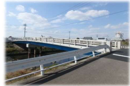
日吉橋橋梁保全事業
