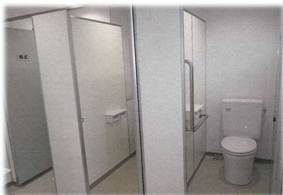
トイレ改修事業
