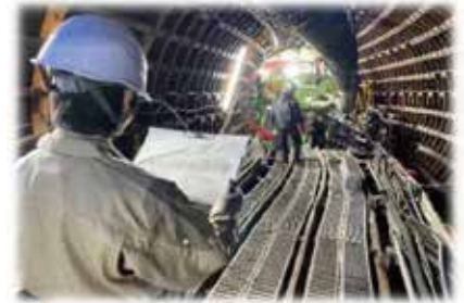
雨水管建設工事
