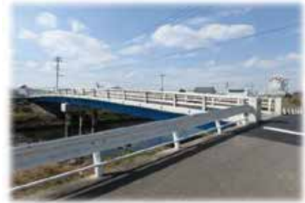
日吉橋橋梁保全事業
