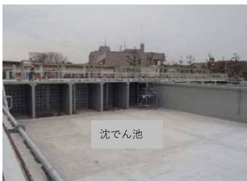
【東部浄化センター沈でん池】
