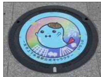
【設置したデザインマンホール】
