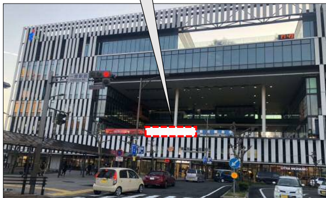
【i-ビル 3階シビックテラスにて横断幕の掲示】
