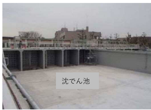
【東部浄化センター沈でん池】
