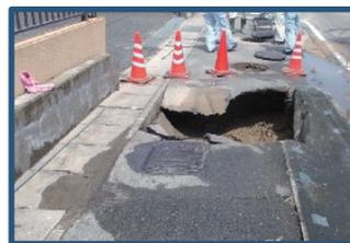
老朽化した下水道管の破損による道路の陥没
