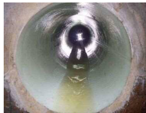
改築工事完成
