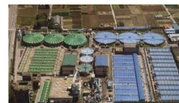
西部浄化センター
