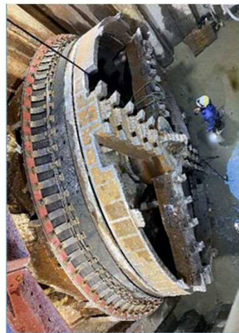
直径4.4mシールドマシン到達 (令和4年11月18日撮影)
