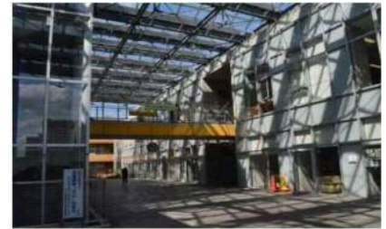
普通教室棟と生涯学習棟をつなぐ 2階テラスとブリッジ
