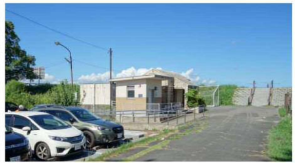
④トイレと堤防部階段
