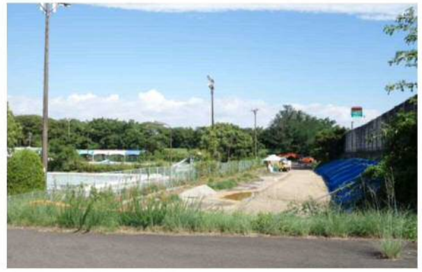
⑨旧尾西プール敷地
