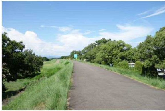
⑧堤防天端（上流側を望む）
