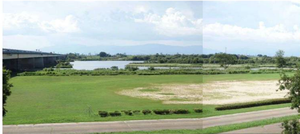
⑫堤防天端からみたグラウンドと木曾川
