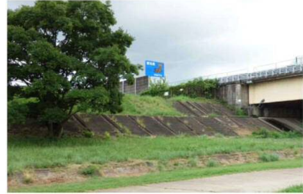
⑪堤防川表（河川敷側）
