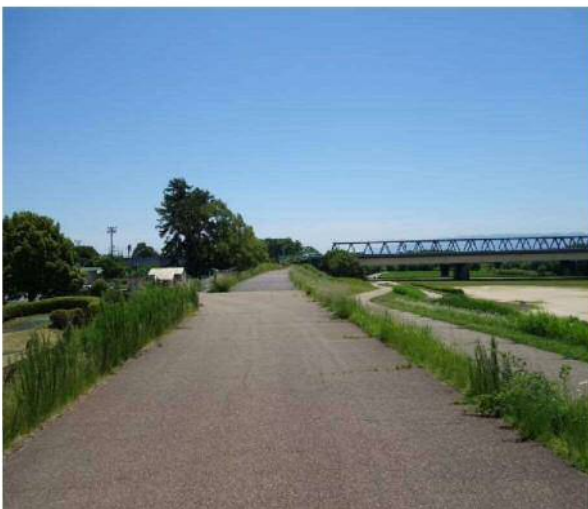
⑦堤防天幅（下流側を望む）
