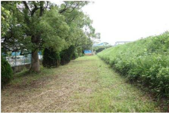
⑩堤防川裏（尾西プール側）
