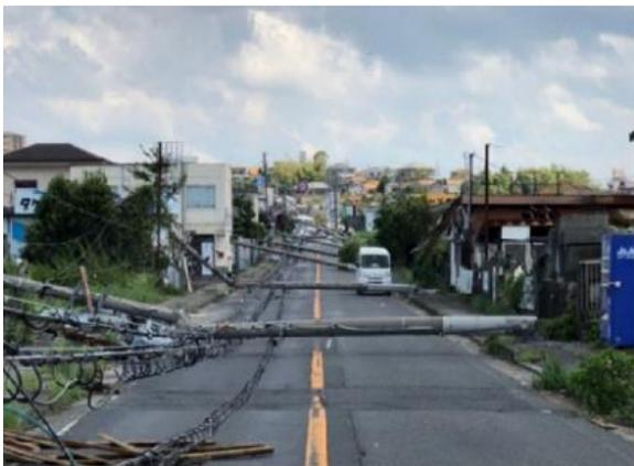
図 2-1 災害時の電柱倒壊による道路閉塞状況
