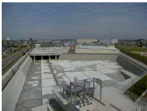
雨水流出抑制施設（伝法寺調整池）
