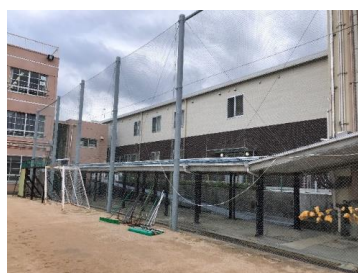
小・中学校共用のグラウンドに隣接して設置し、小・中学校の敷地から直接アクセスできる
