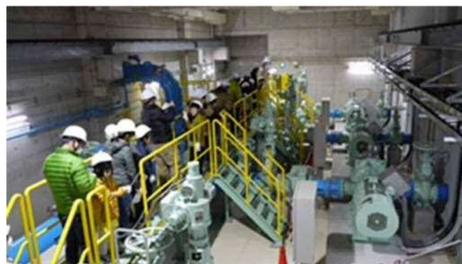
ポンプ棟内部見学
