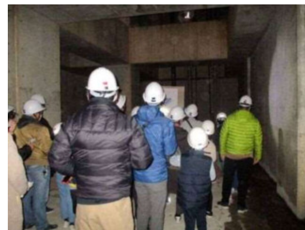
地下 29 m の貯留槽底部
