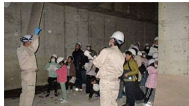
貯留槽内部での説明
