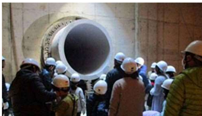
貯留槽への流入管
