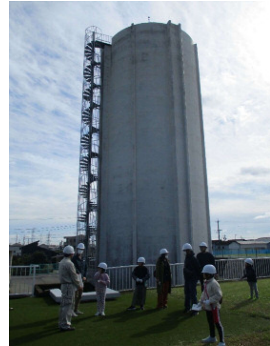
配水池から配水塔を望む
