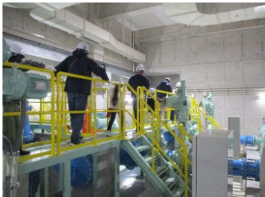
配水ポンプ見学
