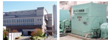
公共施設に電力供給
