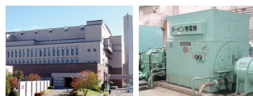
公共施設に電力供給
