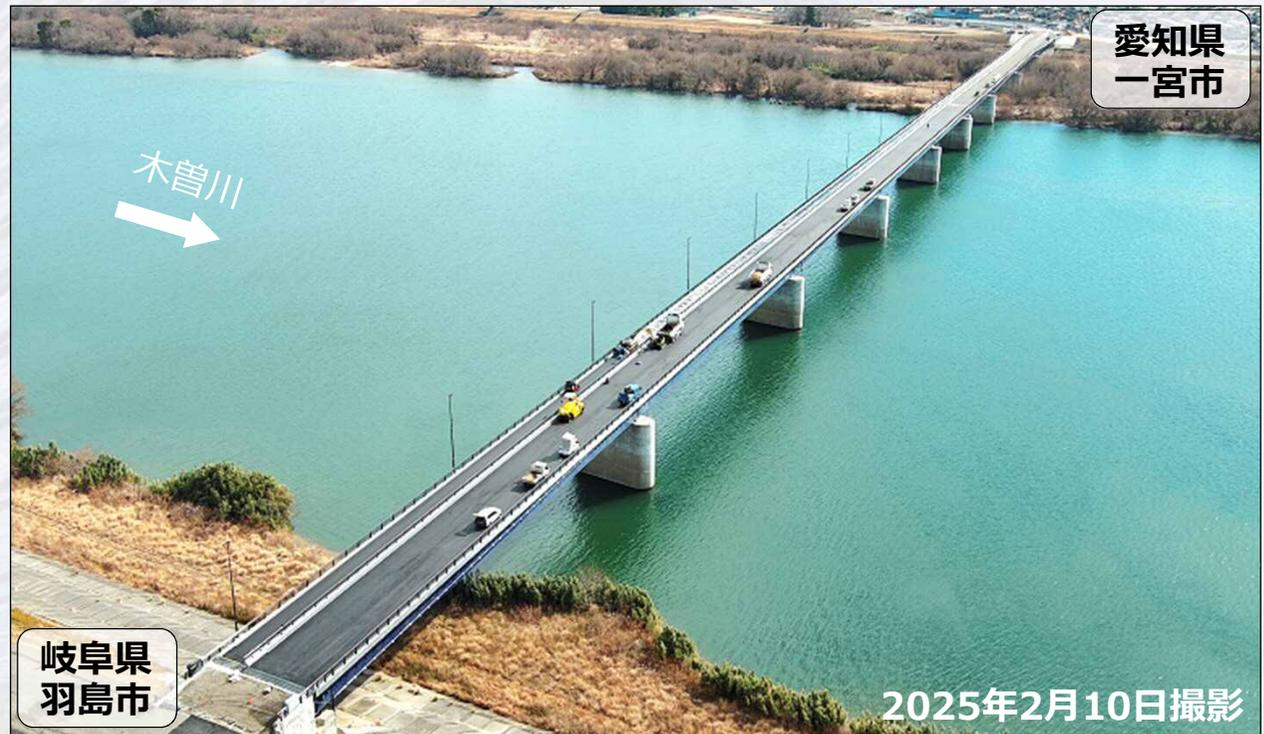
橋の長さ:759m 道路の幅:11.5m(2車線・片側歩道)
