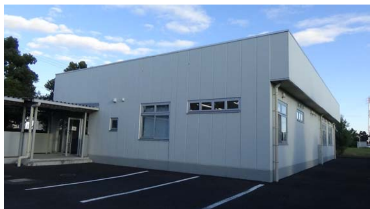
一宮市水道水質検査棟
