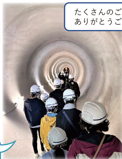
直径3500mm雨水管内部を見学する様子
