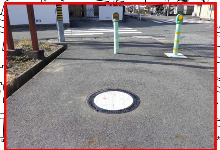
下水デザインプレート設置写真
