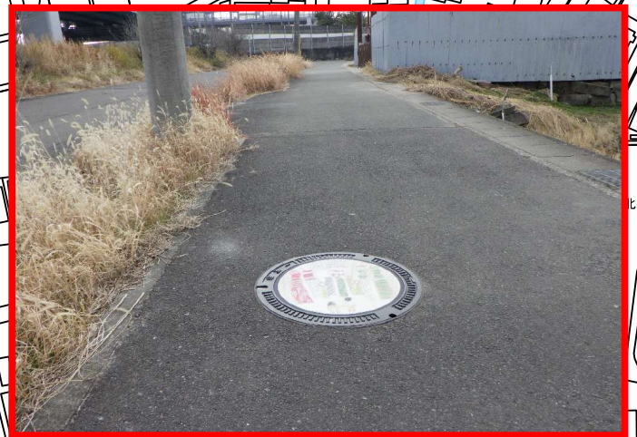
下水デザインプレート設置写真
