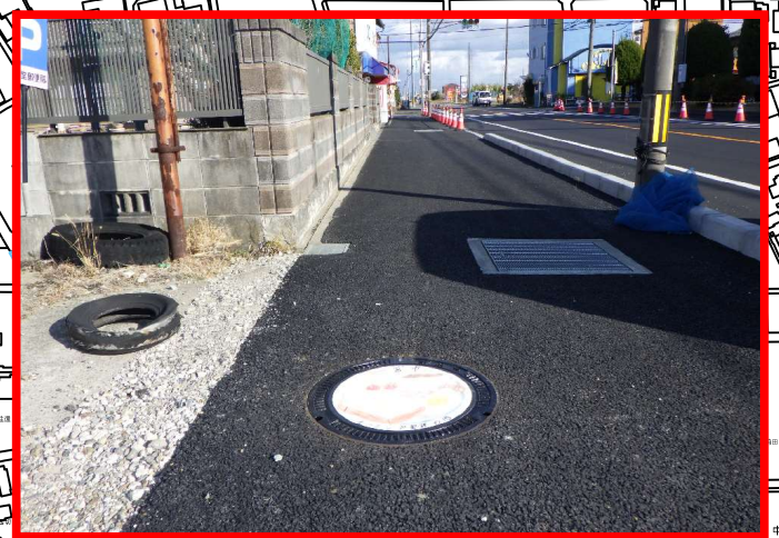
下水デザインプレート設置写真
