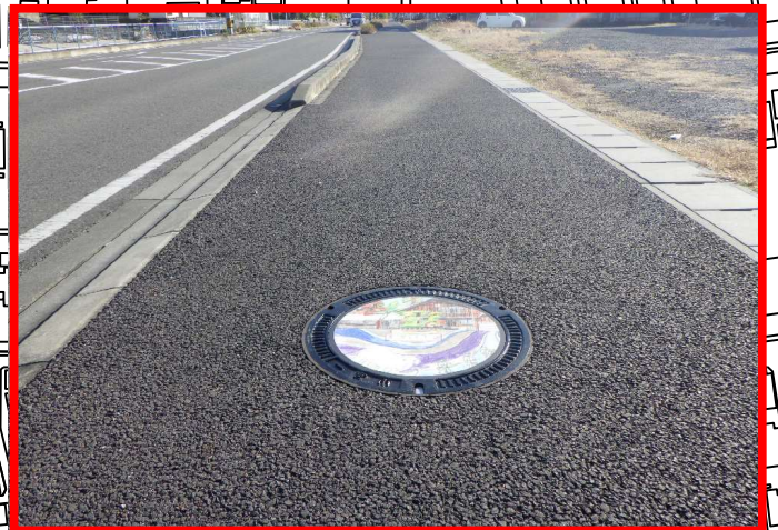
下水デザインプレート設置写真
