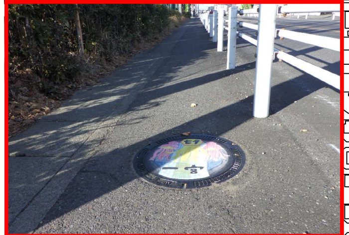
下水デザインプレート設置写真
