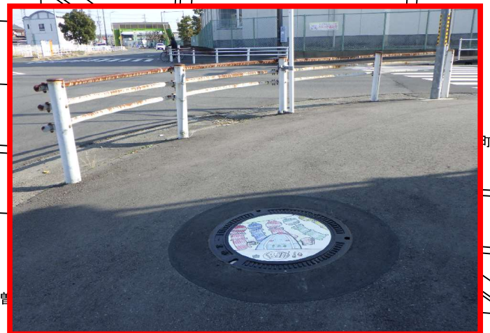
下水デザインプレート設置写真
